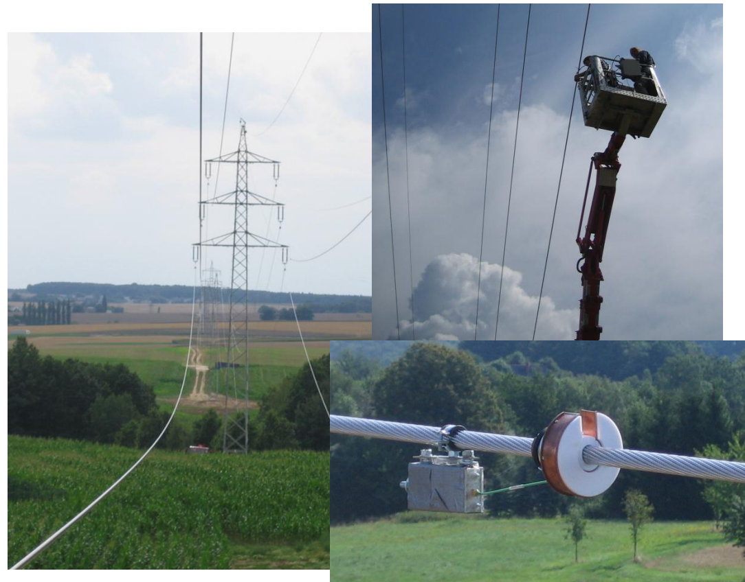
Feldversuch an 110kV Leitung (mit Antennenprototyp und Funkelektronik im Versuchsstadium)
